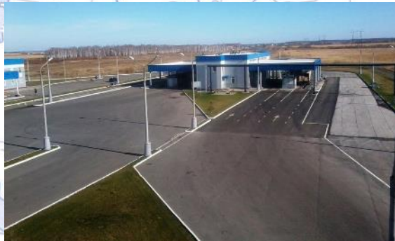
Автомобильные пункты пропуска Петухово, Маштаково
