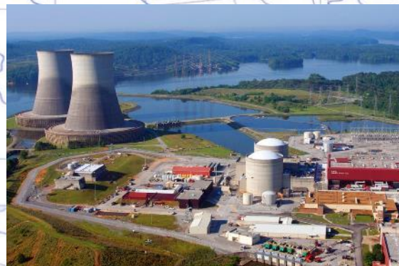
Атомная электростанция г. Аккую, Турция
